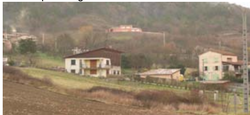
Un bâti résidentiel hétéroclite et éparpillé aux abords des villages
