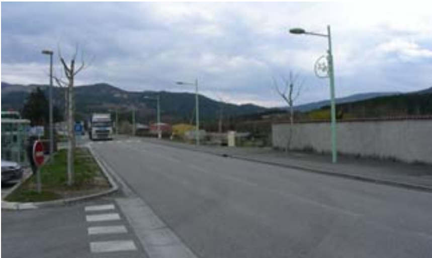
Banalisation des espaces publics avec des matériaux préfabriqués et standardisés mis en place dans une logique "technico-routière" (mur écaillé, mobilier urbain, éclairage public, jardinières ...)
