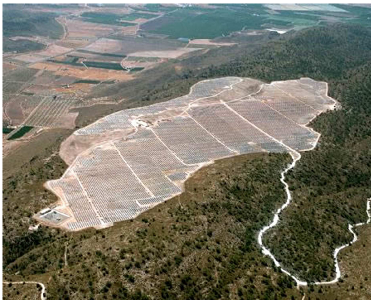
La plus grande ferme solaire du monde, à Jumilla en Espagne : 120 000 panneaux solaires pour une capacité de 20 mégawatts
